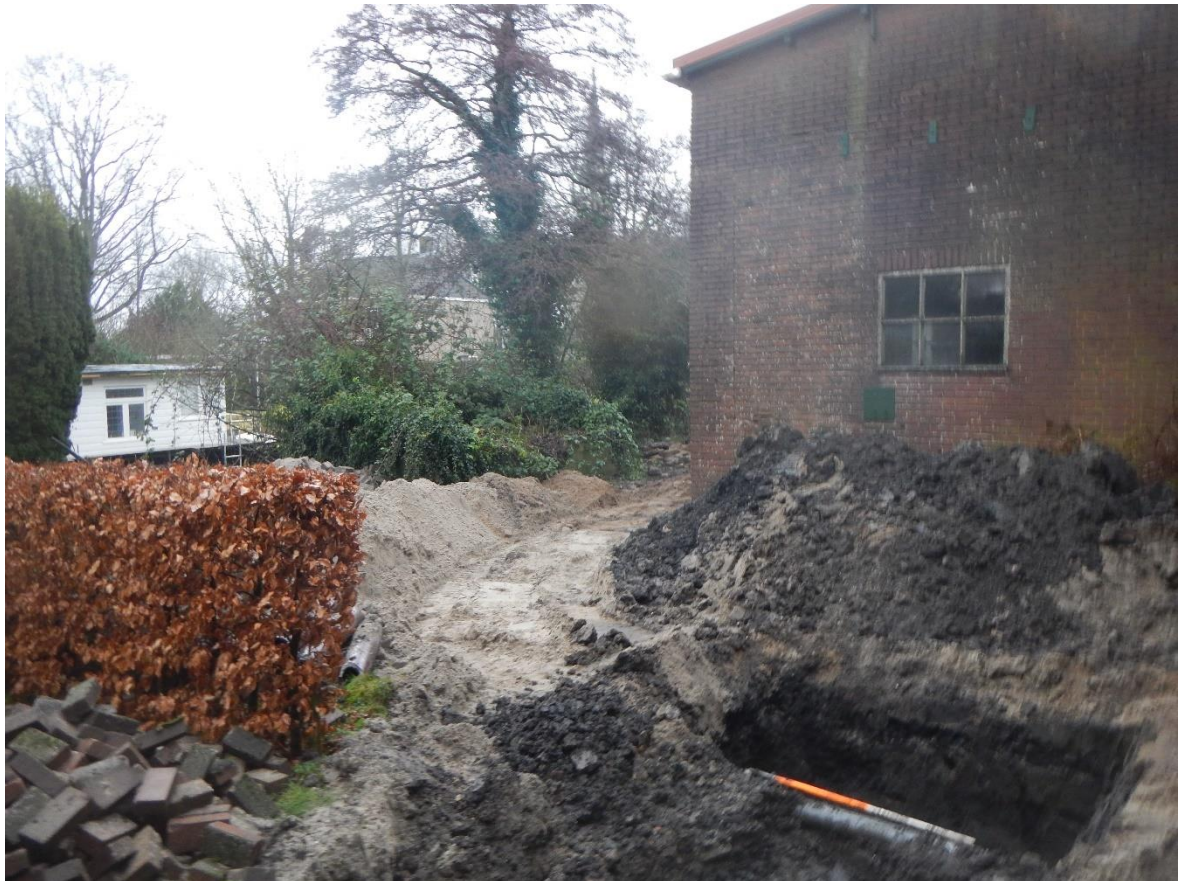
Afbeelding 3. Overzicht van de werkput voor aanvang van de werkzaamheden. (Bron: Synthegra B.V.)
