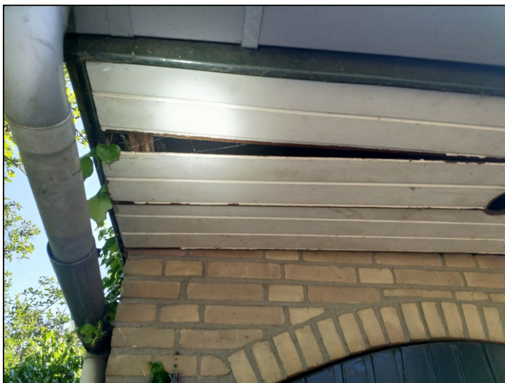
Afbeelding 14: Impressie kapot beschot bij de paardenbox. Foto: C.E. Bakker | Ecoresult B.V.
