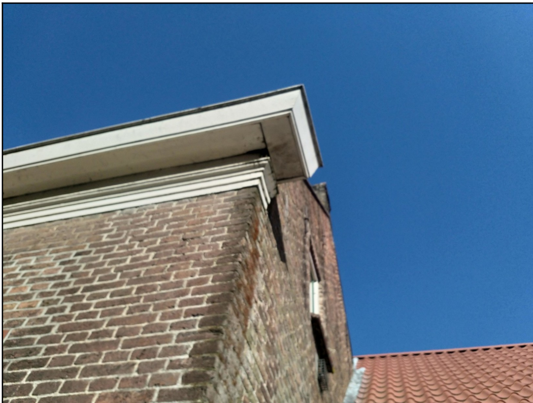
Afbeelding 16: Impressie van de houten omtimmering bij de dakgoten van het woonhuis. Foto: C.E. Bakker / Ecoresult B.V.
