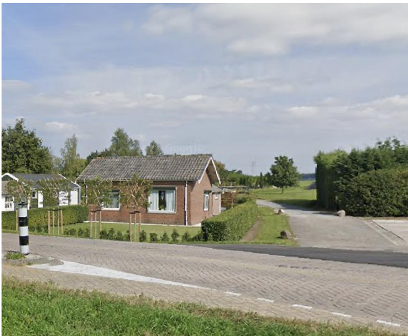
Figuur 2.1: Bedrijfswoning Schenkeldijk 70
