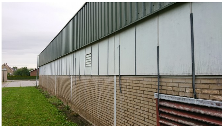
Afbeelding 9: Buitengevel van de loods
