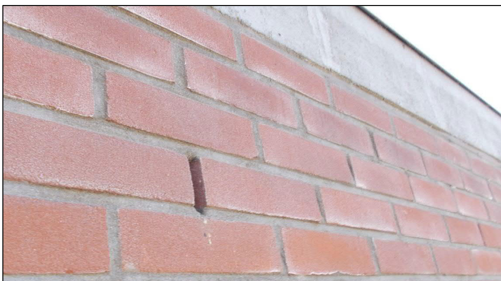
Figuur 3: Stootvoeg in het gebouw
