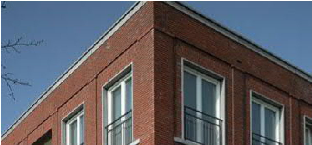
DAKLIJST ACHTERBOUW GEPROFILEERD BETON
