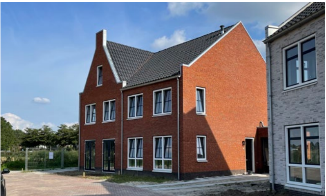
Twee-onder-een-kap woningen Fase 1
