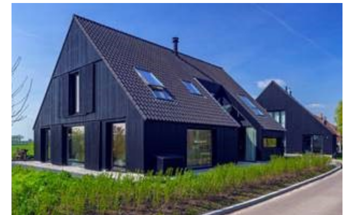
Open gewerkte kopgevel met luiken
