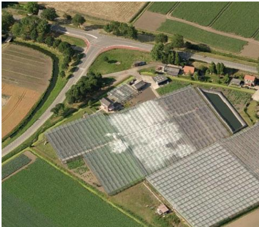
Figuur 3.3: foto bestaande situatie
