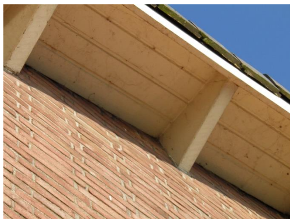
Figuur 13. Aanzicht van het dakoverstek op de kopgevel van de woning.
