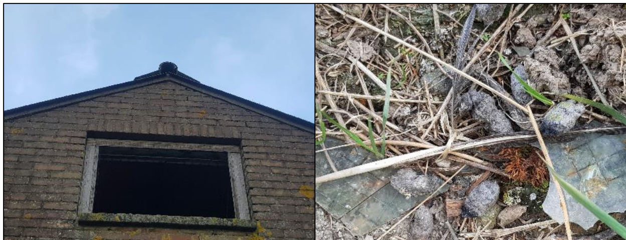
Afbeelding 7: De stenen schuur met in de nok ruimte waar een steenuil in kan broeden (links) en braakballen onder de nok, afkomstig van een steenuil en/of kerkuil (rechts).
