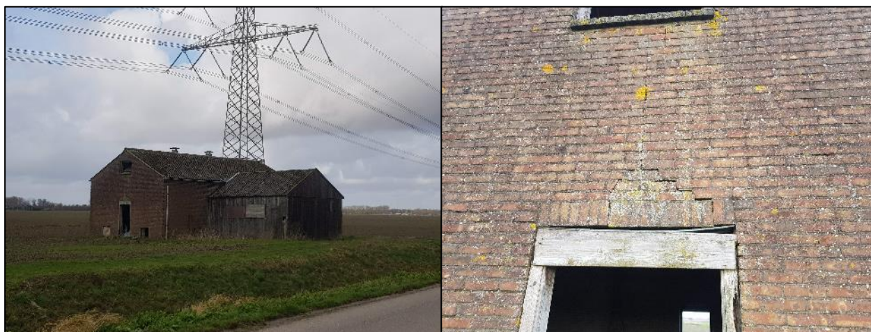
Afbeelding 9: De stenen schuur die door het ontbreken van bomen en struiken vormt als windvanger (links) en kleine lengte schuur in kopgevel (rechts).
