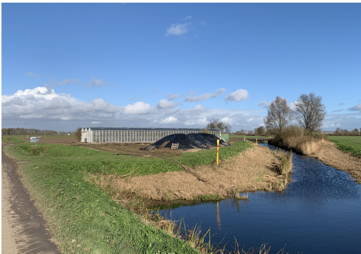
Zicht op de kavel vanaf de zuidzijde, mooie te zien hoe het verloop van de kreek zichtbaarder wordt bij amovering kas
