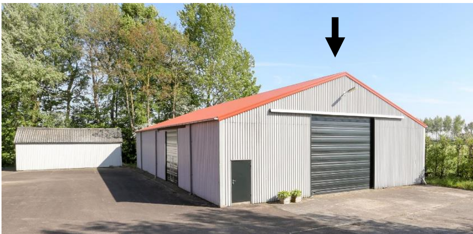
Figuur 1.4 foto metalen schuur die wordt afgebroken
