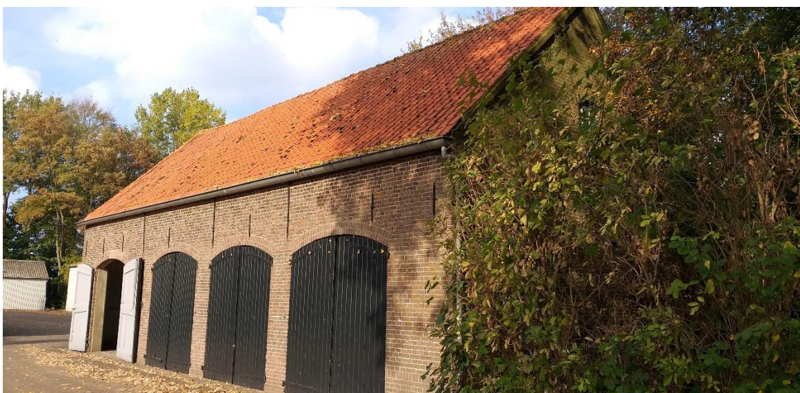
Figuur 6. Aanzicht wagenshuur met platte dakpannen en openslaande deuren.
