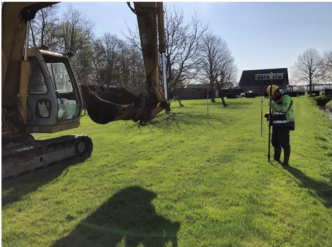
Figuur 3. De werkputten worden uitgezet met behulp van de dGPS.
