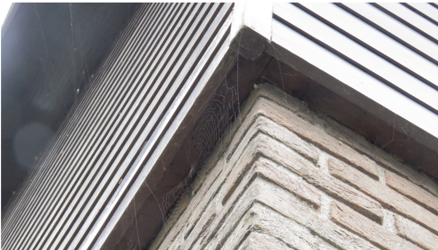
Afbeelding 11: Onderzijde gevelbetimmering Margrietstraat 6, onder de betimmering zijn geen ruimtes aanwezig.
