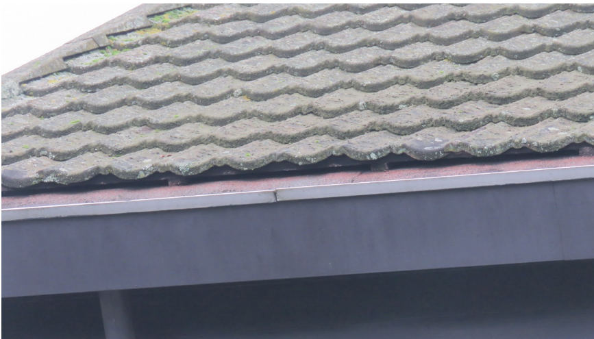
Afbeelding 9: De Margrietstraat 6, ruimtes onder de dakpannen zijn zeer beperkt, de dakpannen zijn ook nauwelijks gewelfd en sluiten zeer nauw aan op elkaar.
