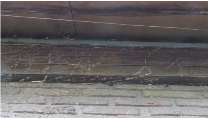
Afbeelding 13: De planken, stalen strips en dakoverstek van Margrietstraat 4 sluiten naadloos op elkaar aan.
