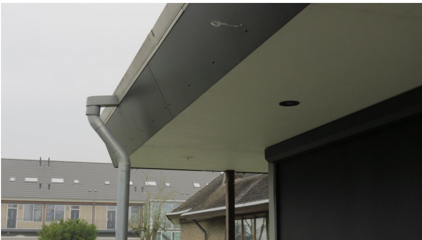
Afbeelding 12: Naadloze afwerking van dakoverstek aan de achterzijde van de Margrietstraat 6.
