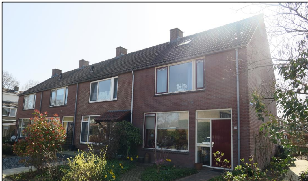
Figuur 4.24 De planlocatie is gelegen aan verschillende straten te Numansdorp en bestaat uit woonblokken opgetrokken uit twee bouwlagen.
