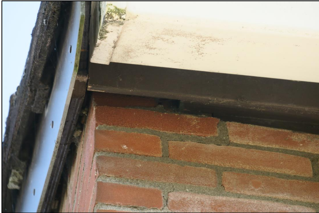
Figuur 4.28 Impressie van de ruimte onder de boeidelen en kantpannen.
