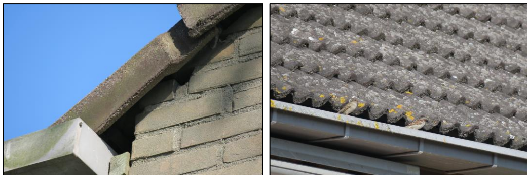
Figuur 4.4 Links: geschikte invliegopeningen onder de kantpannen, waar gierzwaluwen en vleermuizen toegang kunnen krijgen tot de dakruimte en/of de luchtspouw. Rechts: aanwezige huismussen op de dakgoot van de Kijffhoeck.
