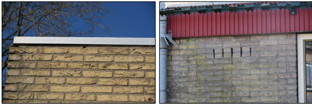
Figuur 4.7 Links: kierende daklijsten in de Thomaskerk. Rechts: open ventilatie-rooster in de basisschool.
