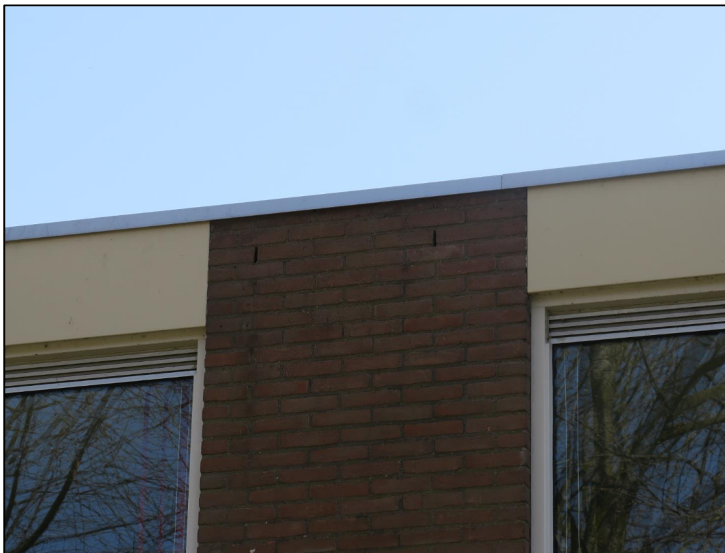
Figuur 4.22 Open stootvoegen en een kierende daklijst biedt toegang tot open luchtsponw.
