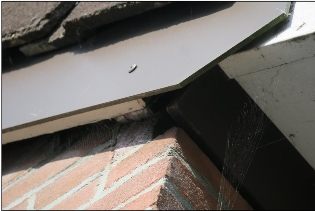
Figuur 4.31 Impressie van de ruimte onder de boeiborden, achter de goot en onder de kantpannen.
