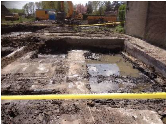
Foto 7: overzichtsfoto ontgraving einddiepte
