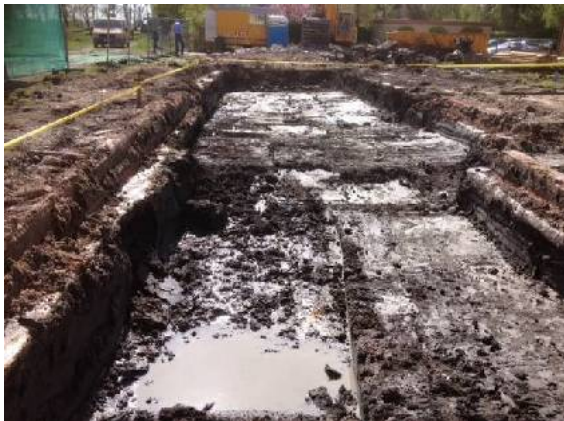
Foto 9: overzichtsfoto ontgraving einddiepte
