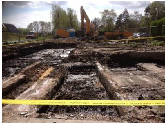
Foto 8: overzichtsfoto ontgraving einddiepte
