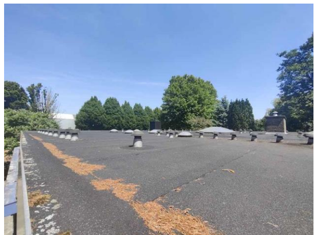
Figuur 15 Platte dak van woonhuis
