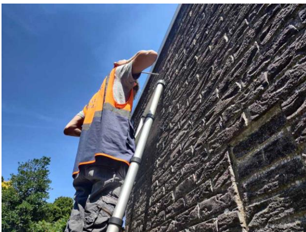
Figuur 16 Onderzoek naar de ruimte in de muur door de stootvoegen
