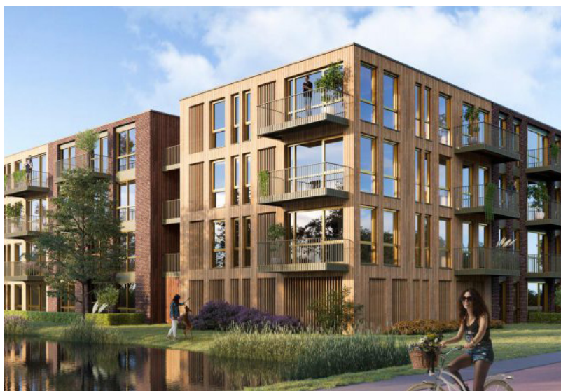
Houten betimmering gecombineerd met metselwerk
