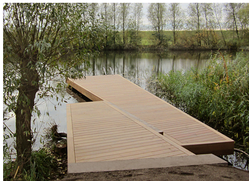
Vlonder, toegang tot water
