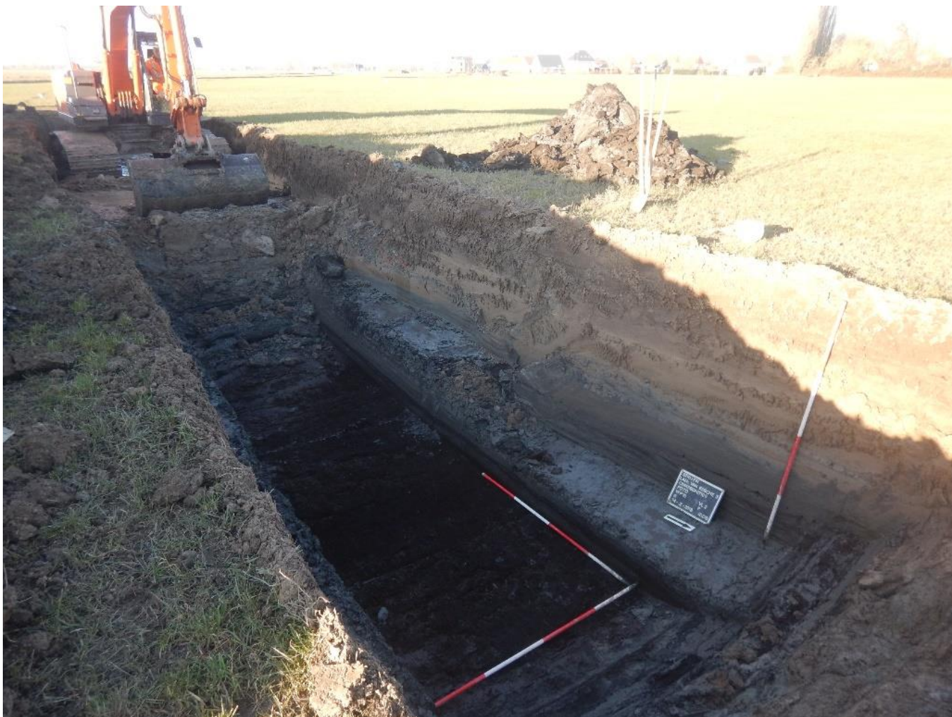
Figuur 9: Vlak 2 van werkput 10 na aanleg.
