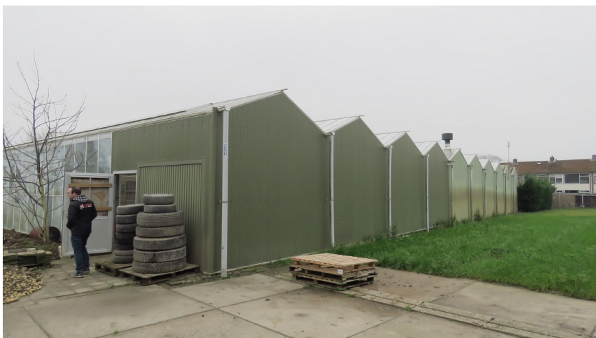
Afbeelding 6: Gebouw I: te slopen kas.
