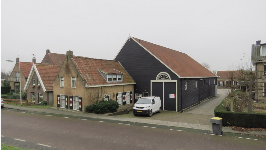
Zicht op plangebied vanaf de straat, dit huis en deze schuur blijven behouden (gebouw A)
