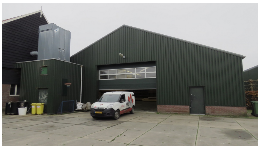
Afbeelding 2: Gebouw B, te slopen loods.
