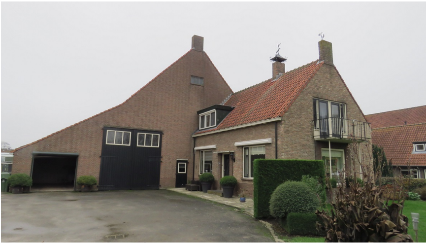
De te slopen boerderij met aangebouwd woonhuis (gebouw C)
