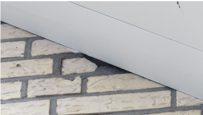
Afbeelding 9: Opening bij dakrand van woonhuis (gebouw J), geschikt voor vleermuizen.
