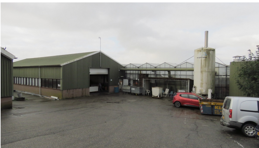
Afbeelding 2: Zicht op de entree van het kassencomplex aan de Oudendijk.
