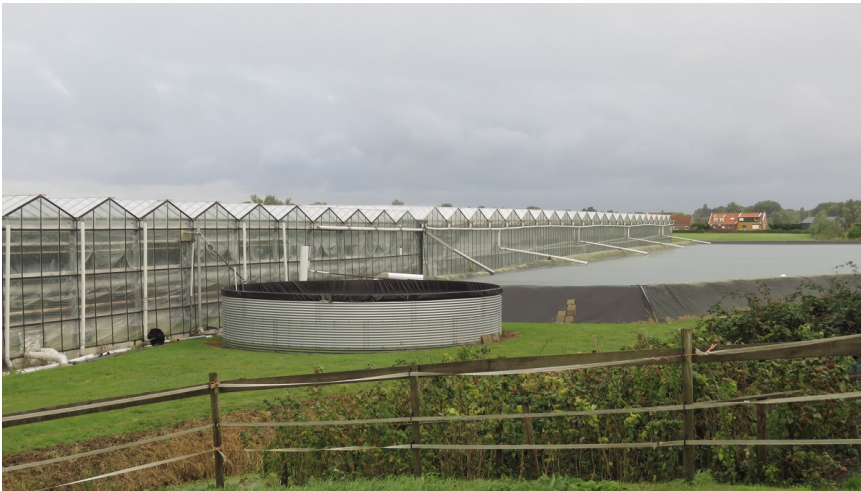
Afbeelding 3: Zicht op de oostzijde van het kassencomplex.
