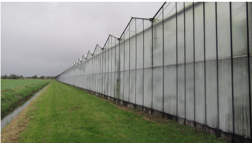
Afbeelding 5: Zicht op de westgevel van het kassencomplex.
