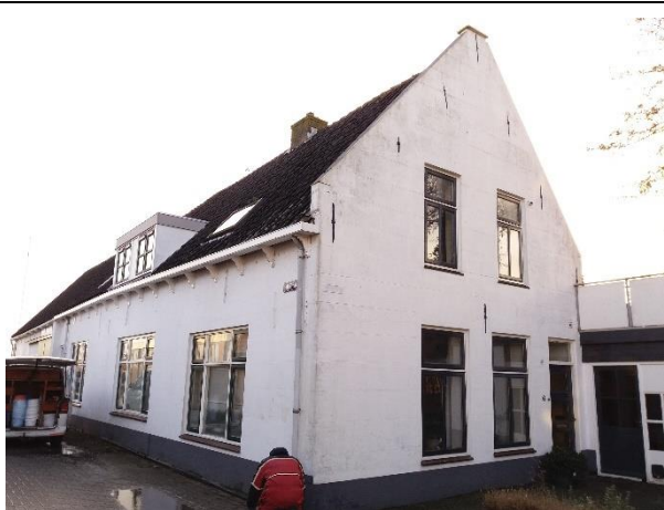
Het grote woonhuis (1) met dakpannen.
