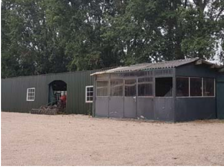
bijschuur waar een deel van gesaneerd wordt
