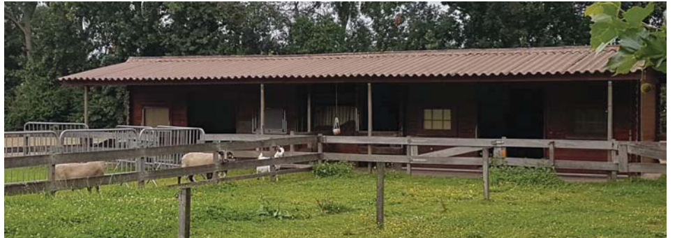
stal die een kleine renovatie zal ondergaan
