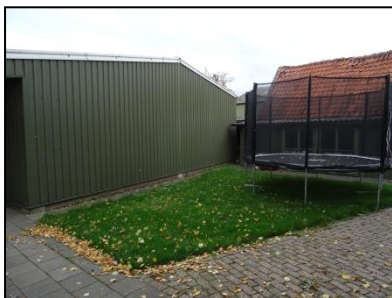
Figuur 9. Te slopen schuur op het zuidwestelijk deel van de onderzoekslocatie (fig. 12, E).
