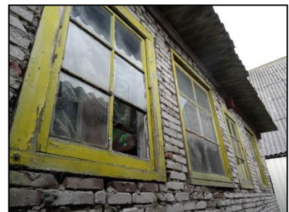
Figuur 11. Westelijk deel van de te slopen schuur op het zuidwestelijk deel van de onderzoekslocatie, bestaande uit bakstenen en een golfplaten dak (fig. 12, E).
