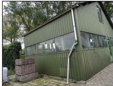
Figuur 7. Te slopen schuur met sandwichpanelen op het zuidelijk deel van de onderzoekslocatie (fig. 12, F).
