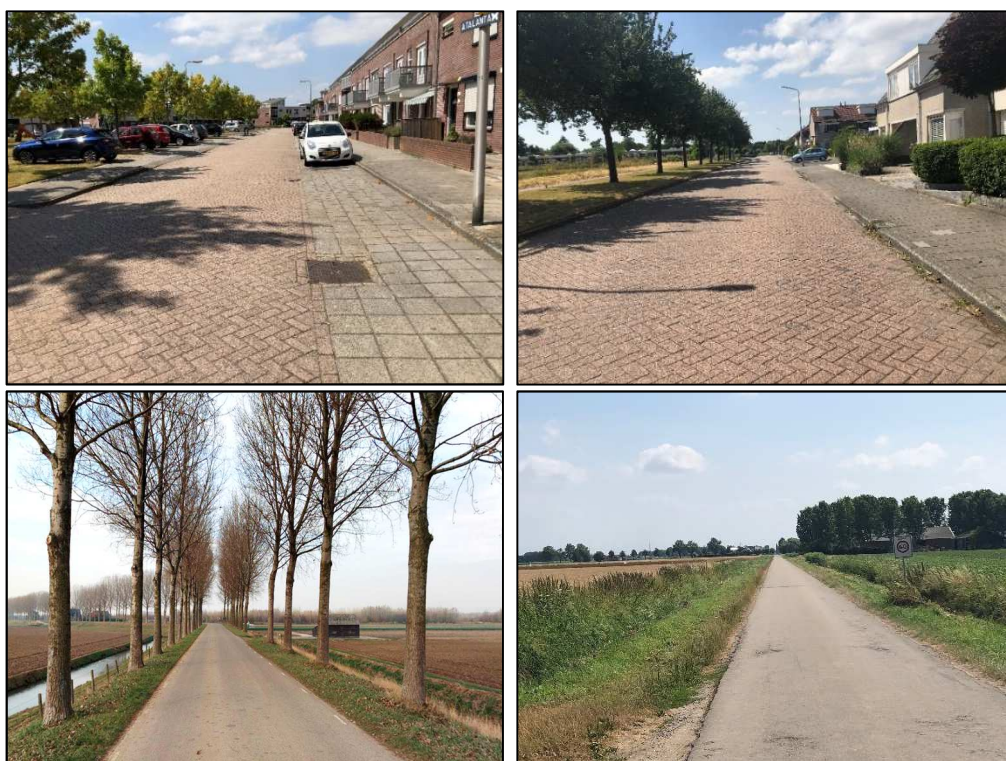
Figuur 2.2: Wegprofiel Atalanta (linksboven), Wetering (rechtsboven), Molendijk (linksonder) en Eerste Kruisweg (rechtsonder). Datum foto's: 17 juli 2018 tijdens schouw op locatie
