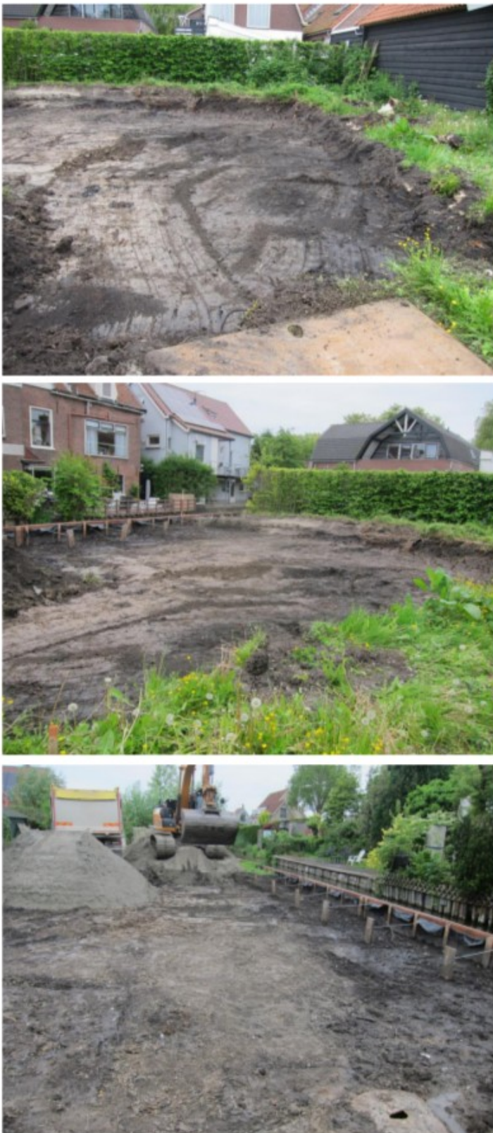
Figuur 14: Foto's van tijdens de sanering.
