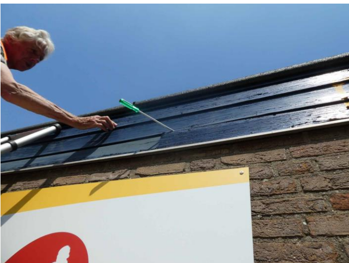
Figuur 13: Controle kieren, de schroevendraaier blijft vrij hangen, wat betekent dat de kieren te smal zijn om te dienen als invliegopening
