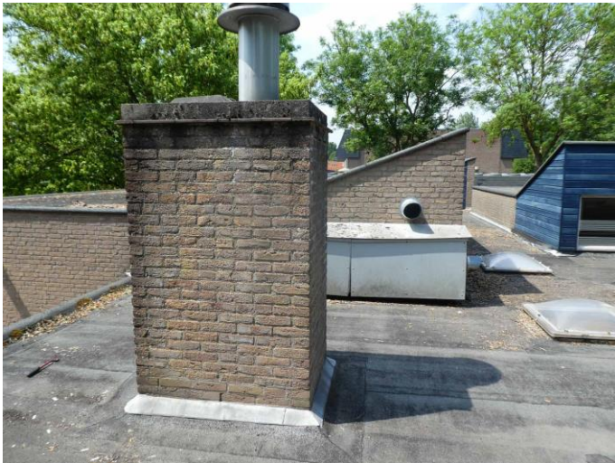
Figuur 11: hoogteverschillen op het dak en schoorsteen
