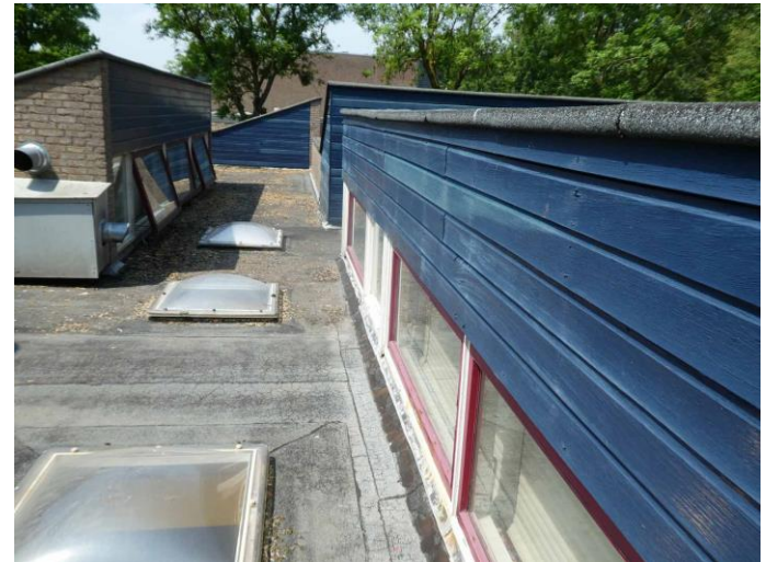
Figuur 5: Dak hoofdgebouw
