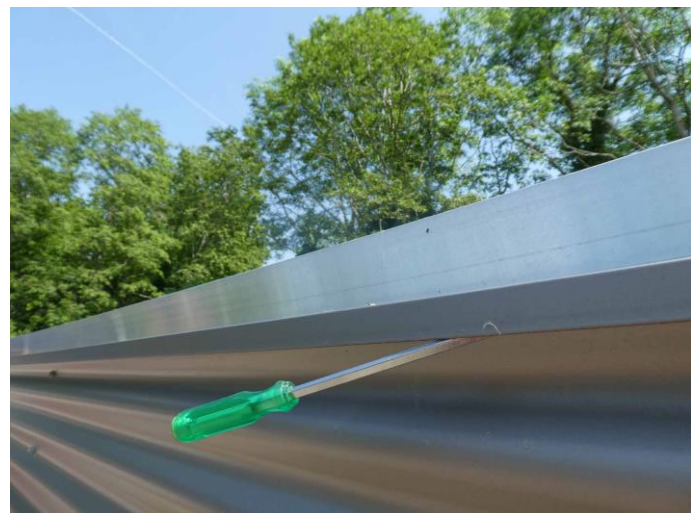
Figuur 16: Controle kieren, de schroevendraaier blijft vrij hangen, wat betekent dat de kieren te smal zijn om te dienen als invliegopening
