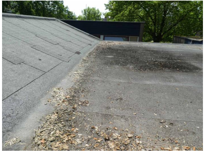
Figuur 10: Dak van het schoolgebouw
