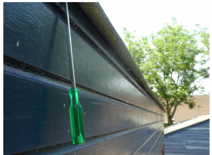
Figuur 14: Controle kieren, de schroevendraaier blijft vrij hangen, wat betekent dat de kieren te smal zijn om te dienen als invliegopening
