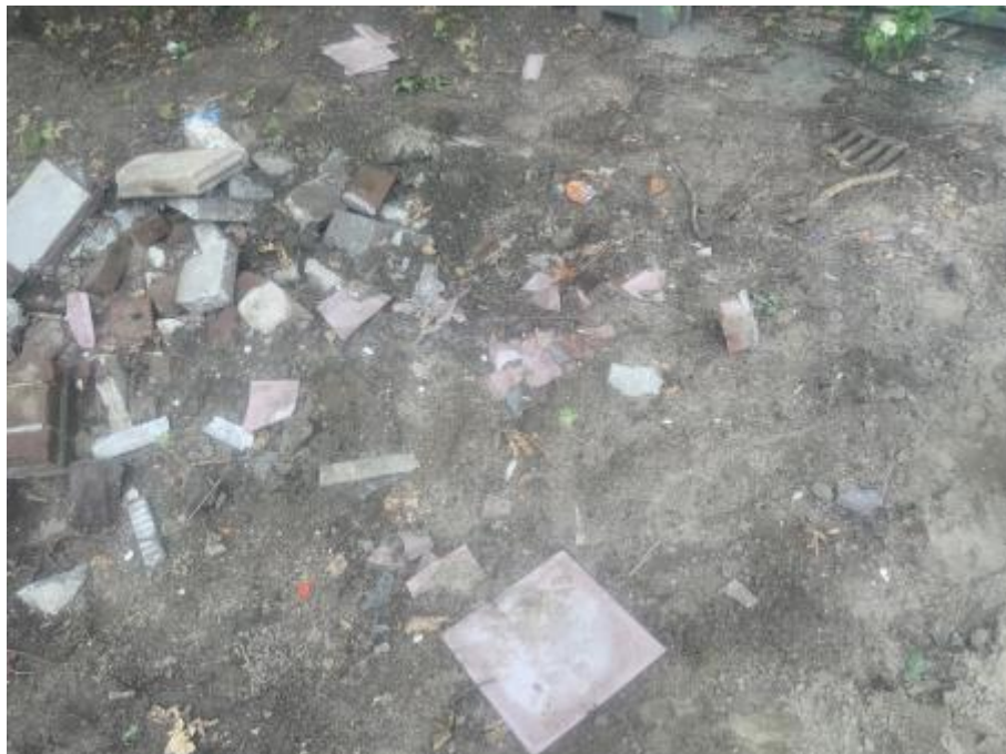
F puin met dakplaten_20220525_132826.jpg
