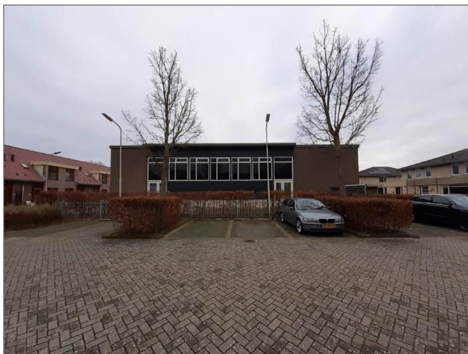
Achterzijde van het evenementen gebouw en parkeerplaats. Foto: L.D. van Drongelen | Ecoresult B.V.
