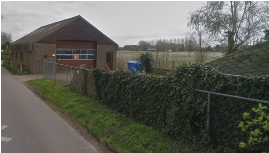
Figuur 2.3 foto bebouwing (westgevel gebouw)
