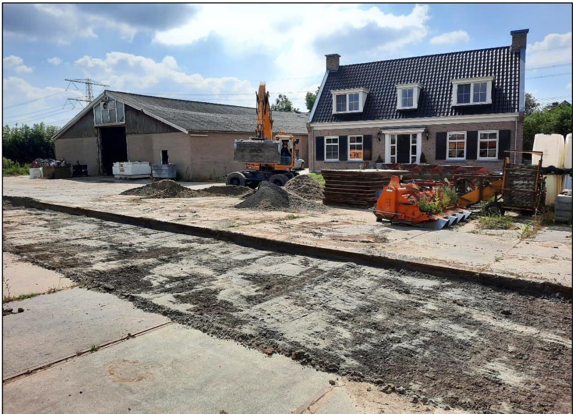
Figuur 8. Werkput3 werd aangelegd ter hoogte van stelcomplatens op het werkterrein binnen het plangebied, waar de landbouwwerktuigen worden gestald.
