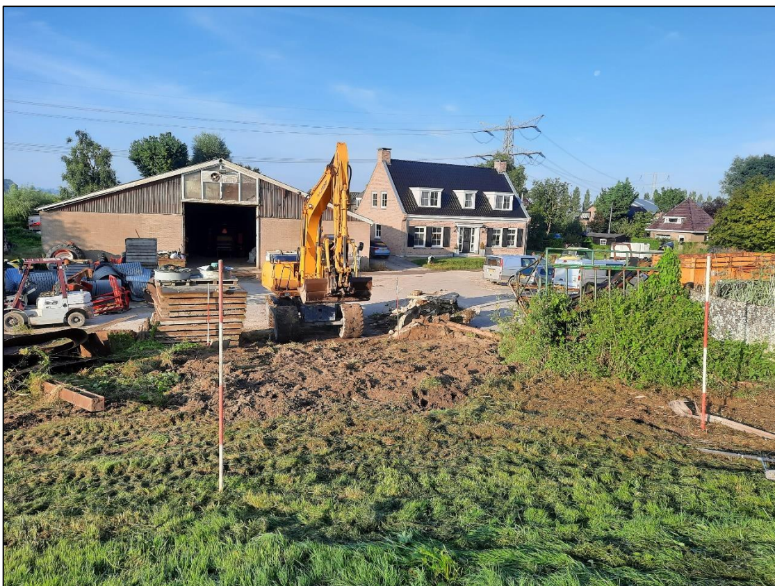
Figuur 3. Het plangebied bij aanvang van de veldwerkzaamheden.
