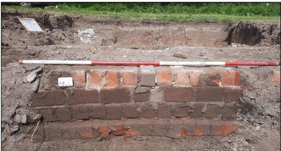
Figuur 17. S.3 is opgebouwd uit dikke, moderne, industrieel vervaardigde bakstenen.
