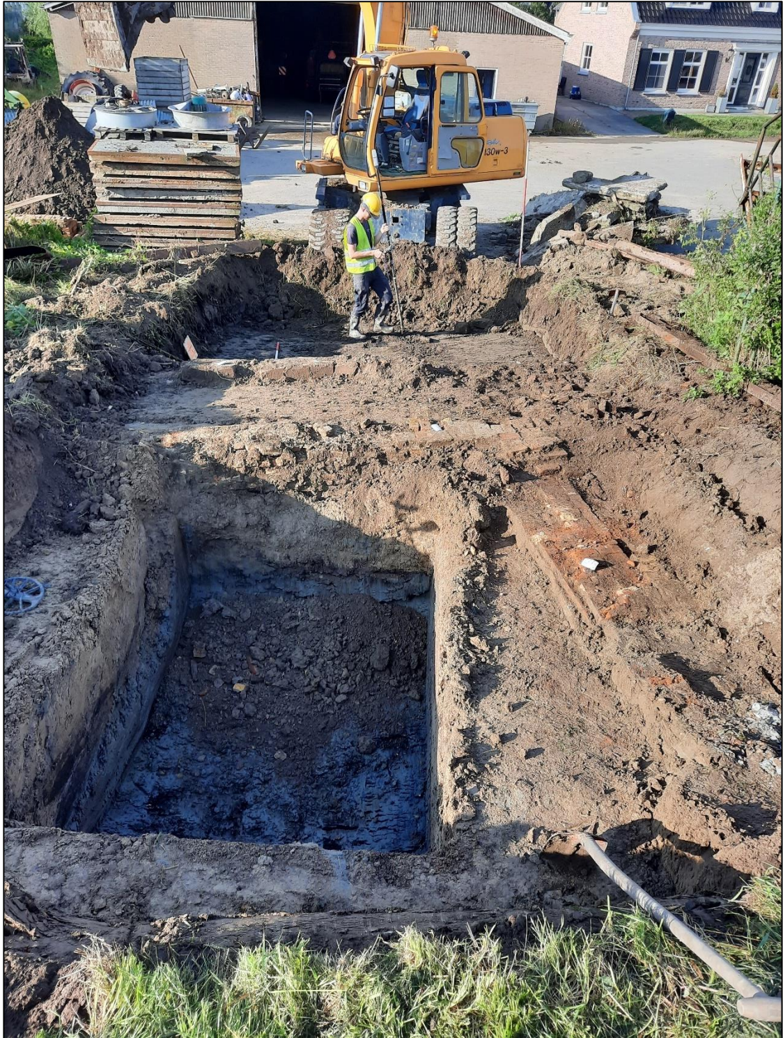
Figuur 5. Overzicht van werkput 1 met tussen de muurfunderingen een dieper aangelegd kijkgat.
