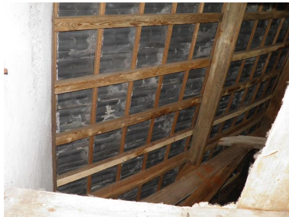
Figuur 12. Het dak van de voormalige stal van onderaf bekeken.
