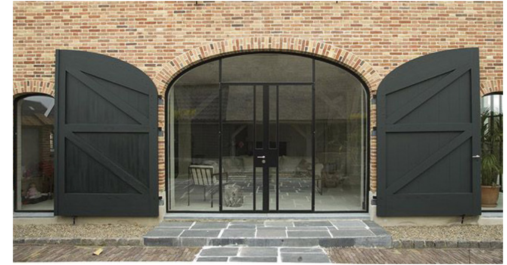
Staldeuropeningen voorzien van moderne kozijnen
