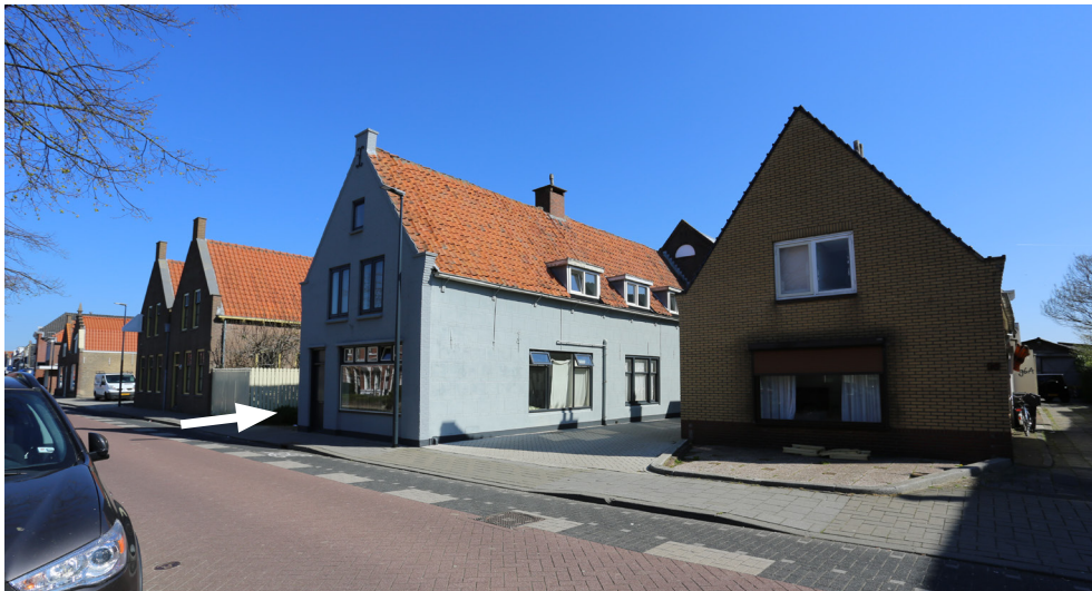
Oostvoorstraat - ter hoogte van ontsluitingsweg plangebied
