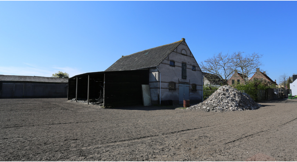
Stenen stal met houten overkapping.
