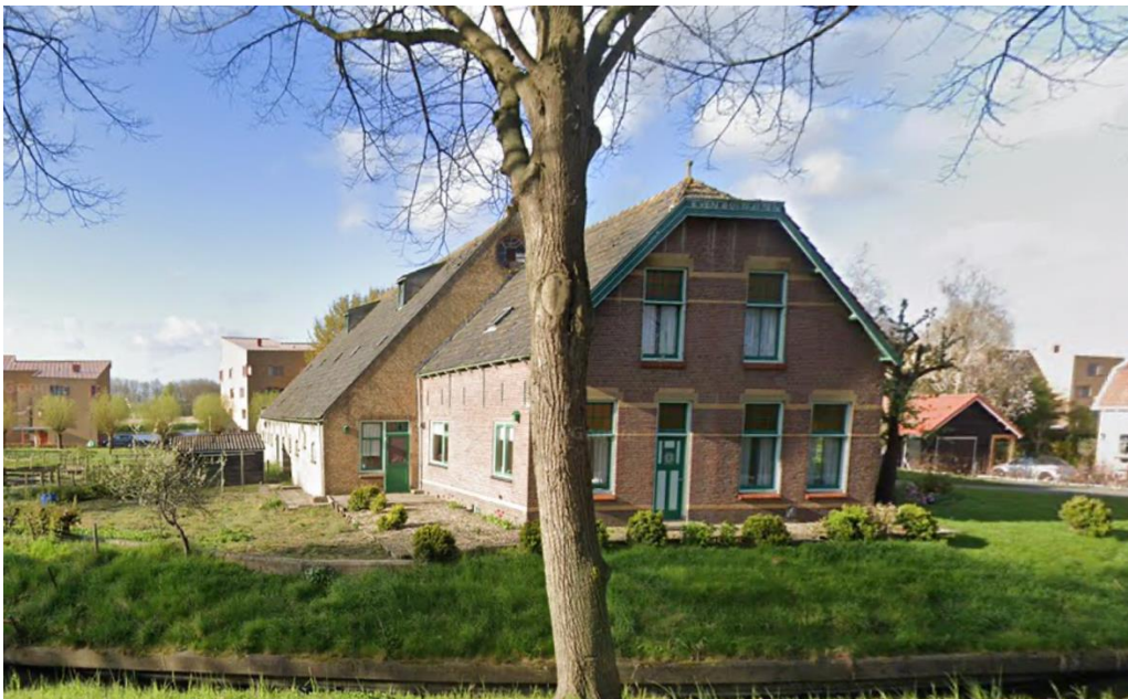
Figuur 2.1: foto boerderij ‘Even Buiten’
