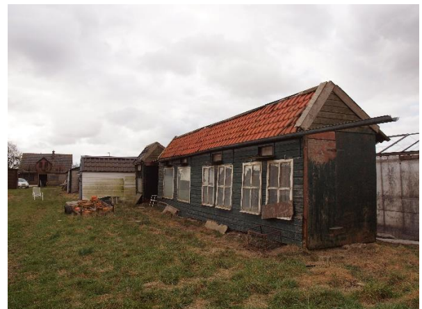
Figuur 9. Het gebouw met de houten duiventillen naast de kassen.
