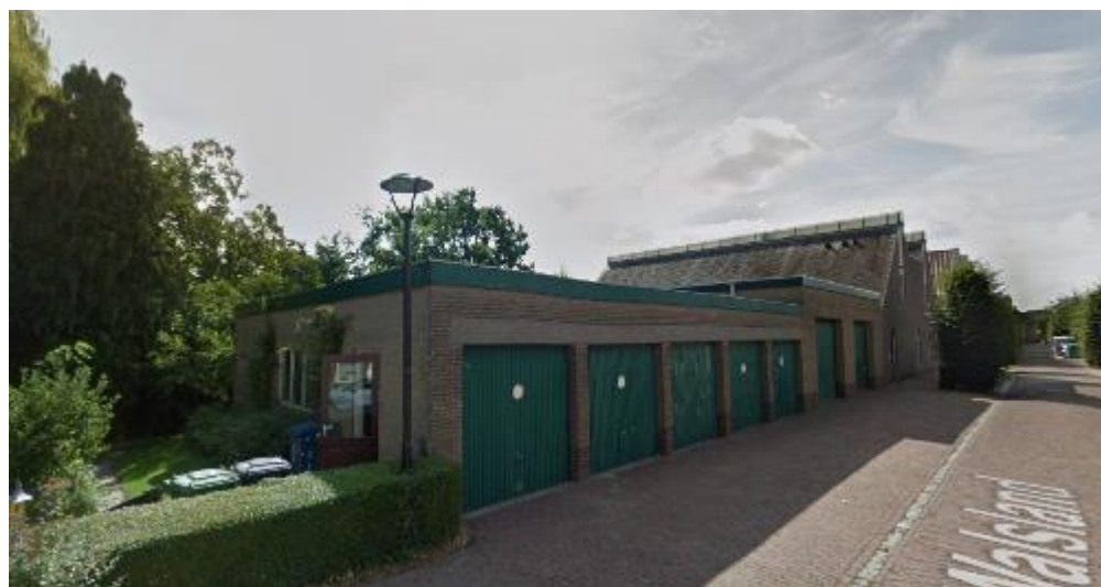
Figuur 2.1: Zicht op vrijstaande woning vanuit noorden (boven) en op bedrijfsloods vanuit het noorden (onder) (Bron: Google Maps)
