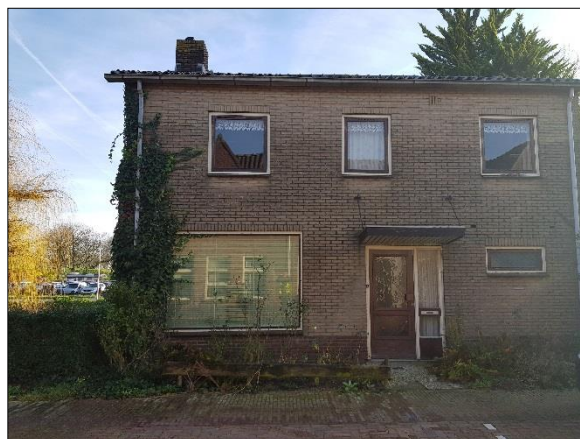
Figuur 5. Woning aan Walsland 44 gezien vanaf Walsland
