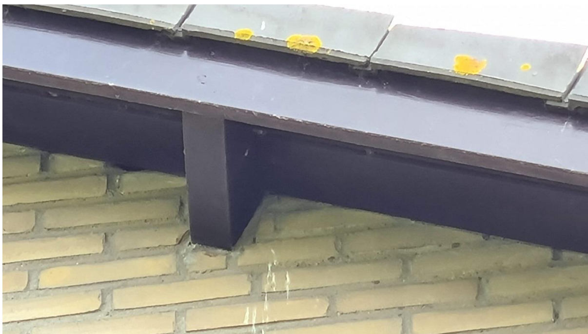
Figuur 12. Details muur van de woning
