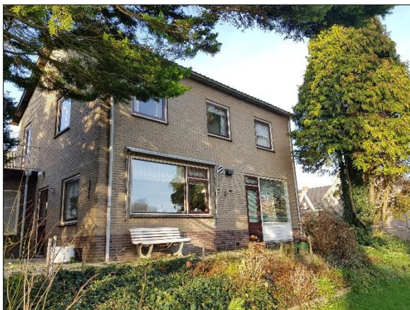
Figuur 6. Woning aan Walsland 44 gezien vanuit de tuin
