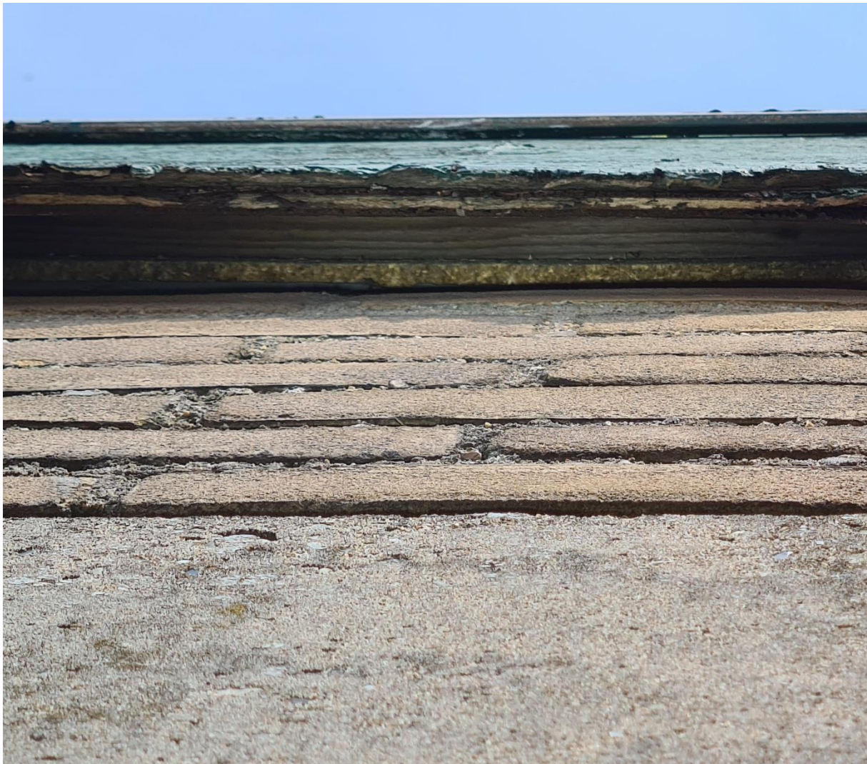
Figuur 14. Detail beplating garage
