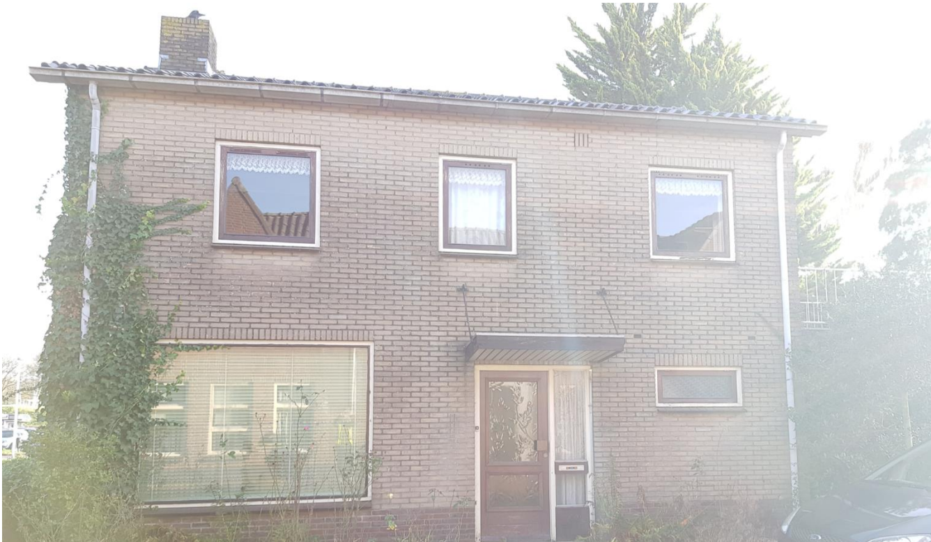
Figuur 1: Woning aan Walsland 44 gezien vanaf Walsland
