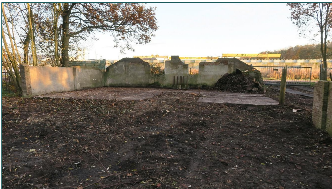
Figuur 3 Overzicht van de fundering en de losstaande muren.
