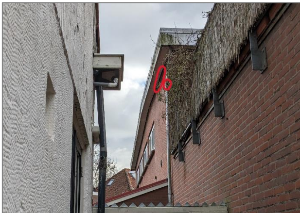
Afbeelding 2.1 | Twee zomerverblijfplaatsen gewone dwergvleermuis, 1 verblijf onder dakbeschot, 1 verblijf naast regenpijp. Burgemeester Jonkheer Hoeufftlaan 8-10.
