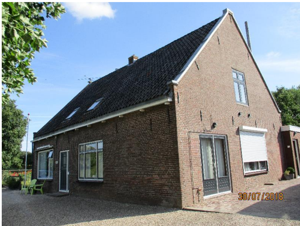
Figuur 1 Het perceel is gelegen aan de Lekdijk 8 en 10 te Tienhoven. Het betreft een voormalige agrarisch bedrijf. Op de foto is de woning aan de Lekdijk 10 zichtbaar.
