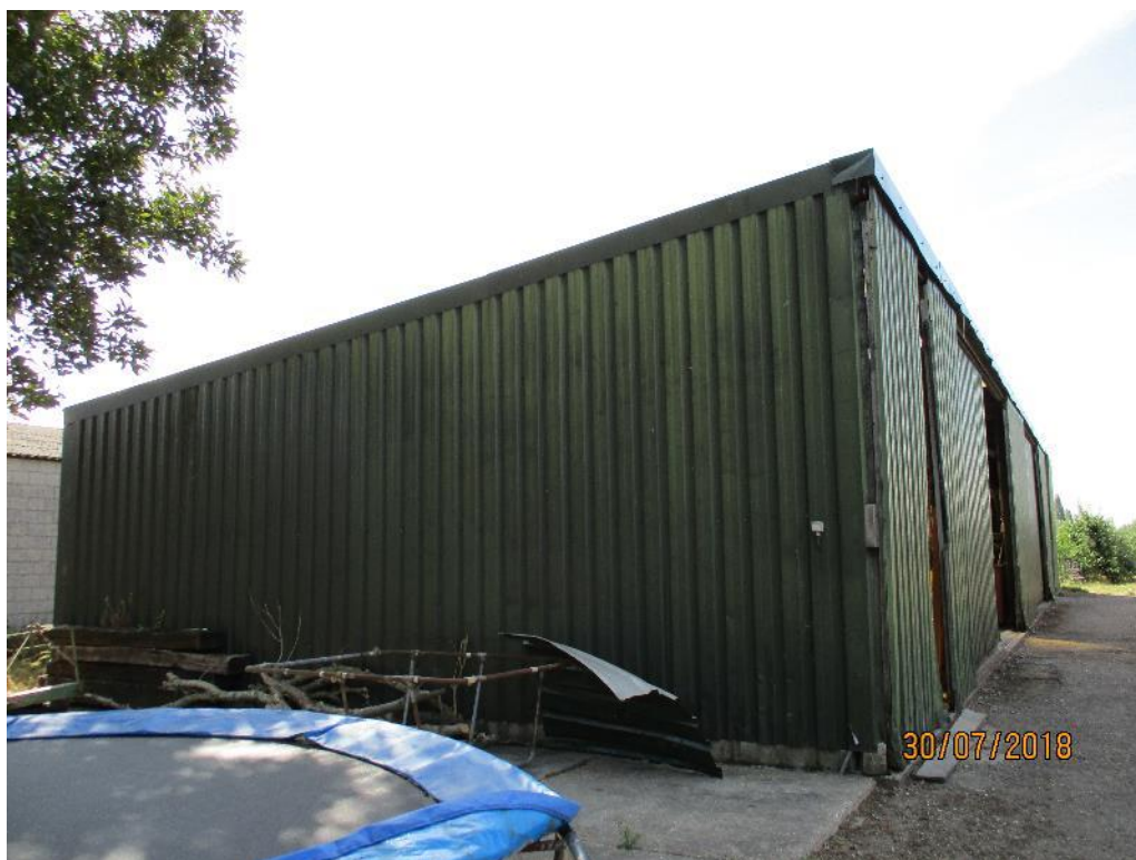
Figuur 3 Een van de schuren is opgetrokken uit damwandplaten en een golfplaten dak.
