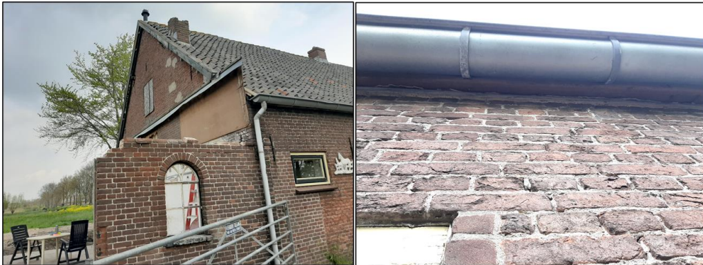
Figuur 5 De loodslabben sluiten strak aan op de dakpannen. De regenpijpen bieden tevens geen weggroei ruimte (links). Onder de dakgoot is geen ruimte aanwezig (rechts).
