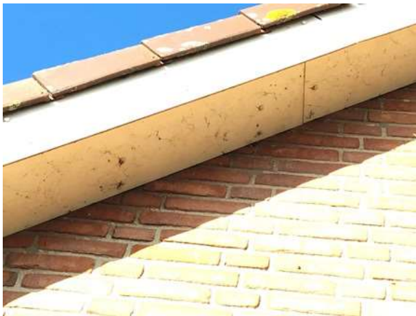
De betimmering is strak tegen de buitengevel geplaatst. Hierdoor kunnen vleermuizen géén verblijfplaats bezetten achter de gevelbetimmering.
