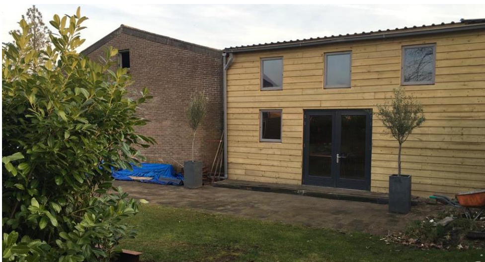
Afbeelding 4: Bestaande loods achterop het perceel
