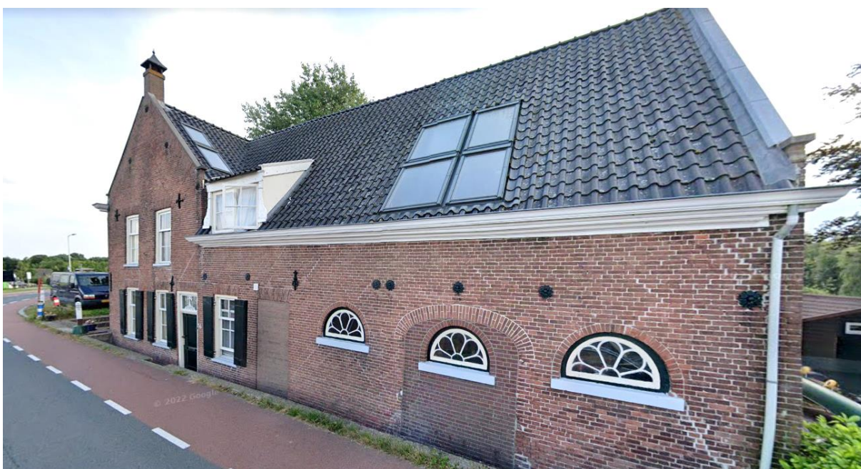
Afbeelding 5: voormalige dijkbewakingshuis tegenover het gemaal
