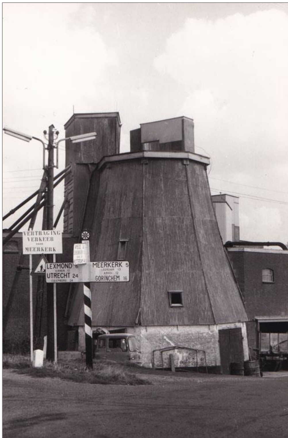
Afb. 11c Foto van de Sluismolen (opname 11 september 1971)
