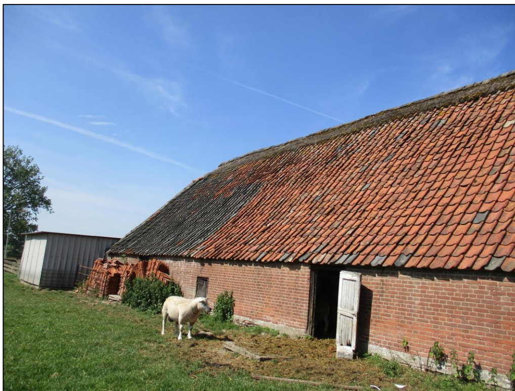
Figuur 1 De oostgevel van de stal D.
