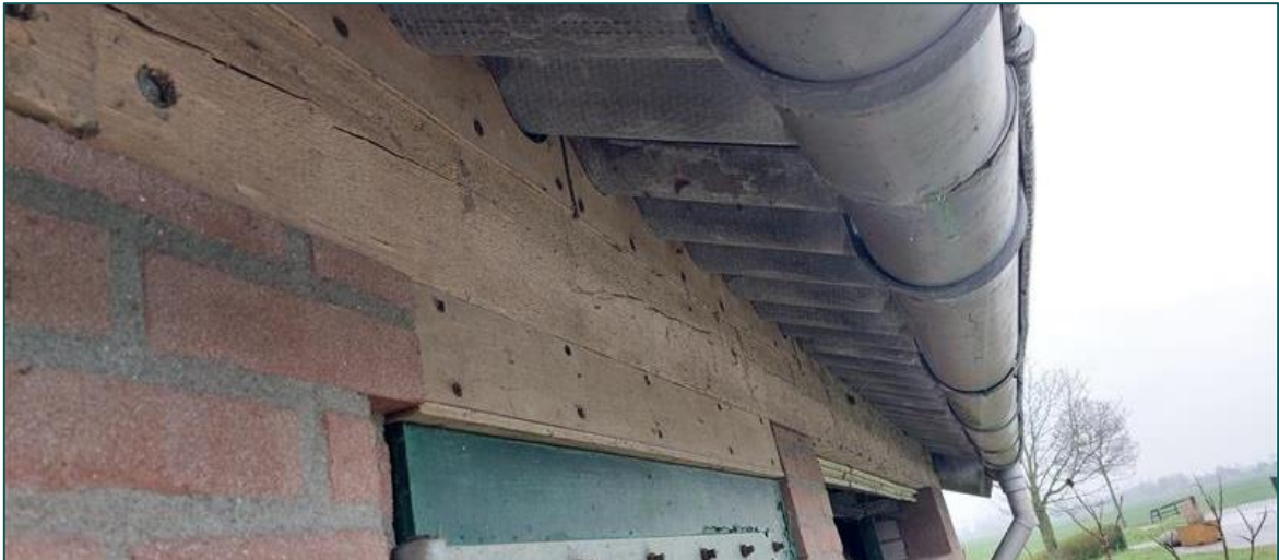
Figuur 3.2 De dakruimte van schuur 1 is niet toegankelijk via de bollingen van het golfplaten dak.
