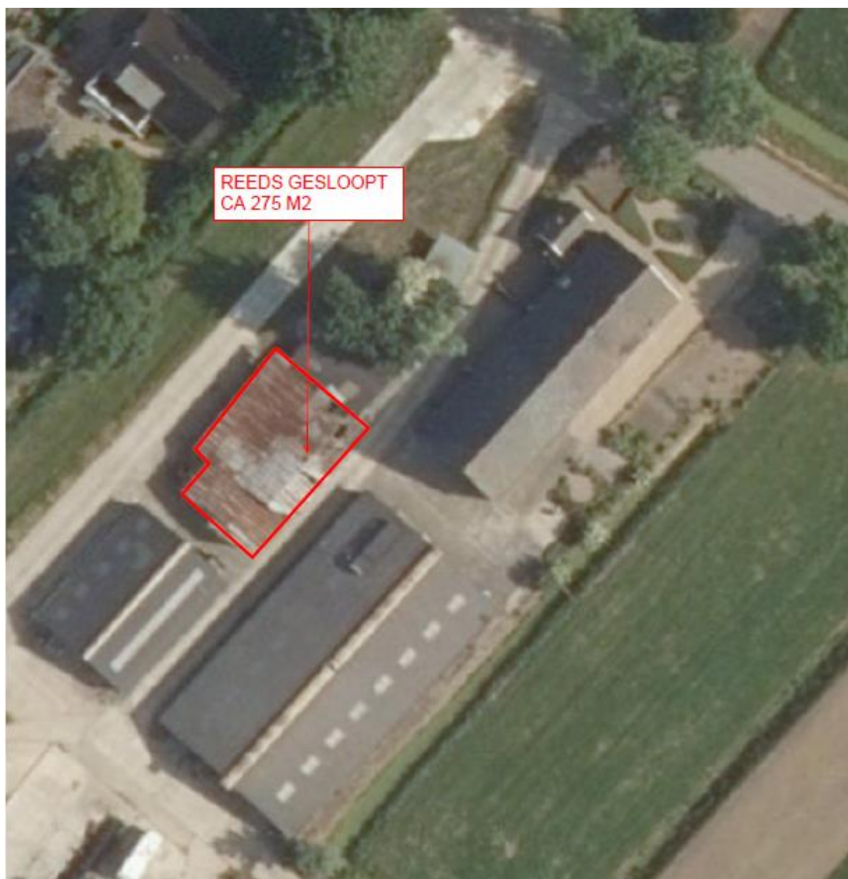
Figuur 6. Luchtfoto met reeds gesloopte bebouwing. (Bron: Langerak Tekening- en Adviesbureau)
